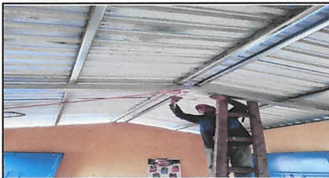
Foto 6: Instalacion de sistema electrico en cocina
