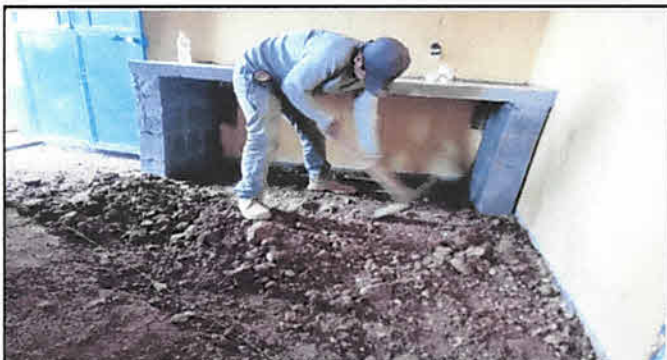
Foto 3: Demolición y Extracción de piso de concreto en cocina
