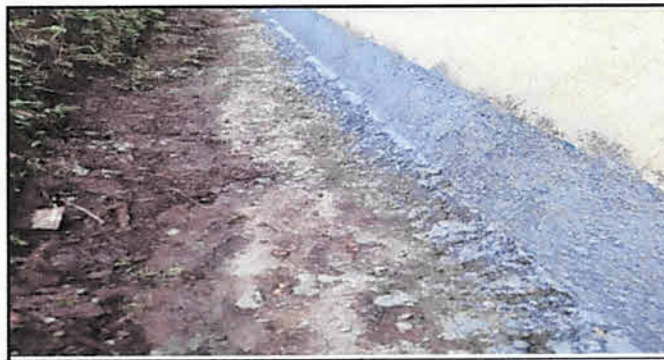
Foto 12: Zócalo de granciado de cemento
