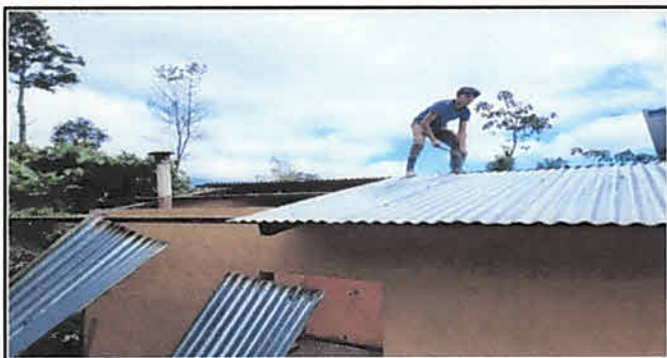
Foto 5: Sustitución de Lámina por lamina troquelada calibre 26 en cocina
