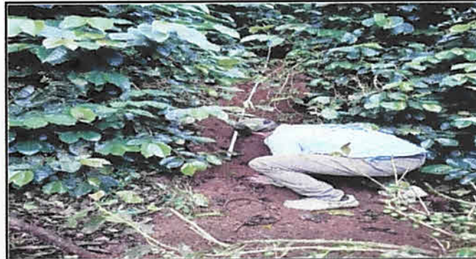
Foto 15 : Sustitución de Tubería principal
