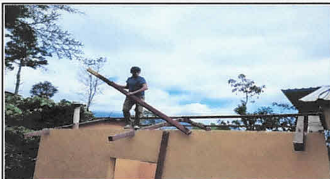
Foto1: Cambio de Estructura de soporte de madera por metal
