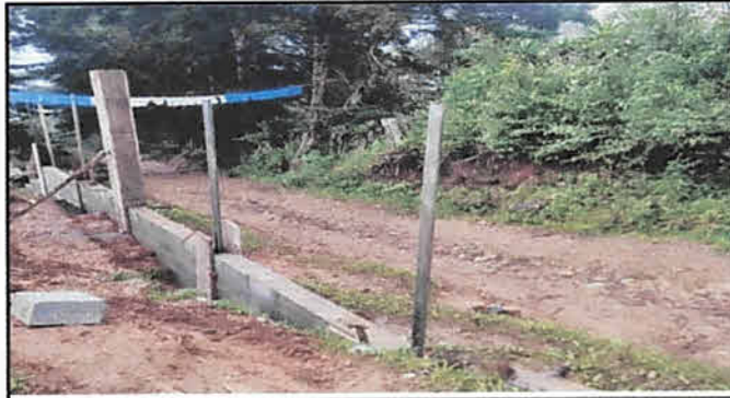
Foto 13: Reparación de muro perimetral de block con tubo HG y malla galvanizada, soleras intermedias y columnas
