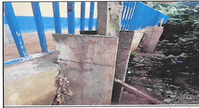
Foto 17: Reparación de muro en corredor con 6 columnas de 2 mts alto y 1 bigueta de 16 mts largo
