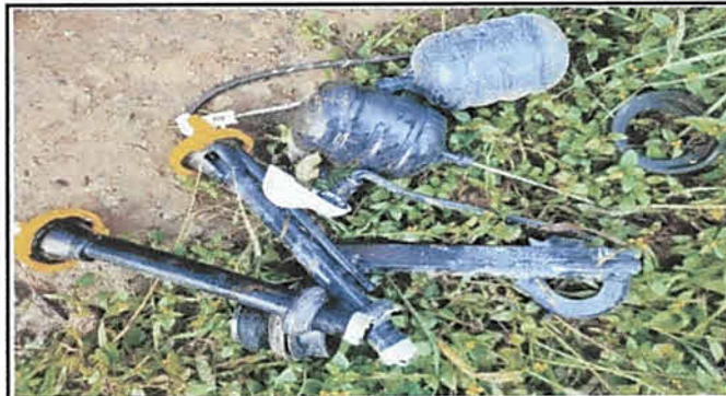
Foto 10: Sustitución de accesorios en sanitarios
