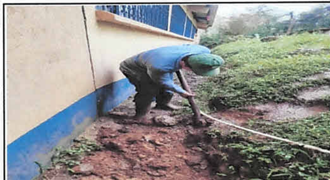
Foto 14: Sustitución de Tubería principal
