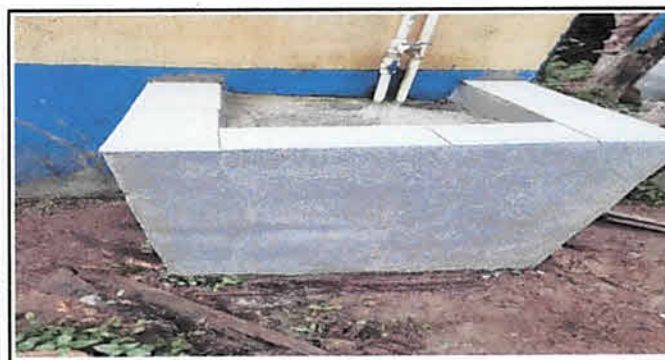
Foto 11: Reparación de Lavamanos
