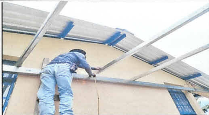
Foto 7: Sustitución de Lámina y estructura en galera
