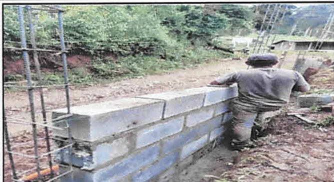
Foto 12: Reparación de muro perimetral de block con tubo HG y malla galvanizada, soleras intermedias y columnas
