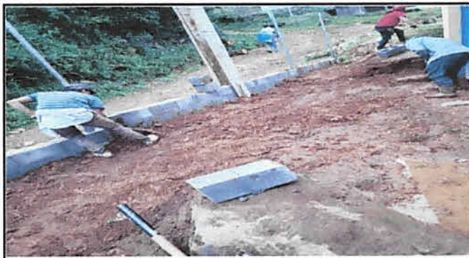
Foto 8: Demolición y Extracción de piso concreto en galera
