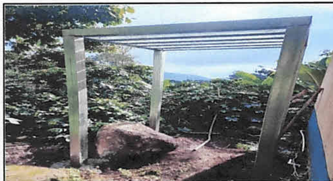
Foto 9: Instalación de Deposito de Agua con Accesorios
